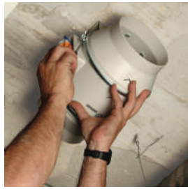
Colocar el cuerpo motor.
