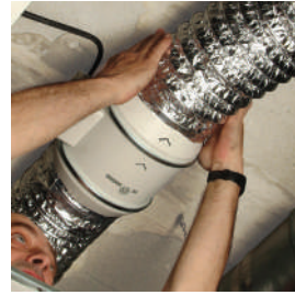
Acoplar los conductos.
