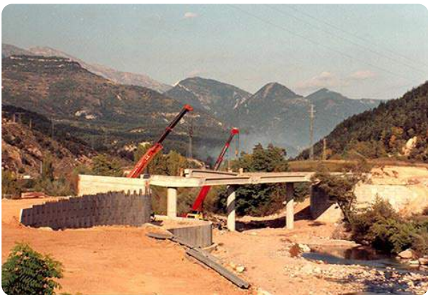
Construcció del túnel del Cadí i la millora de les carreteres del municipi Arxiu Josep Viladés
