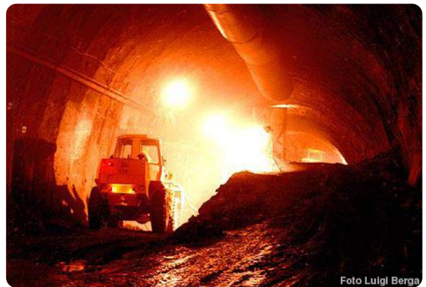
Construcció del túnel del Cadí i la millora de les carreteres del municipi Arxiu Foto Luigi
